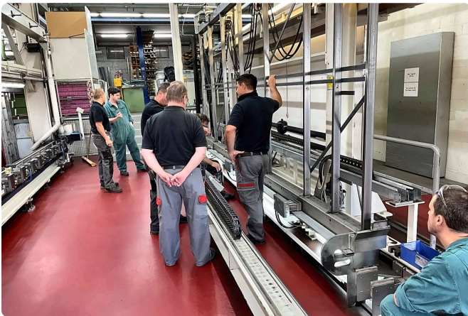
Inbetriebnahme des neuen Steuerungssystems.
