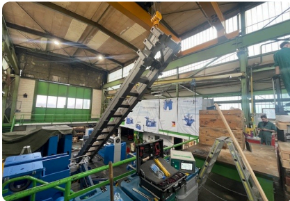
Das Unterbett kommt in die Grube und wird danach gefüllt.
