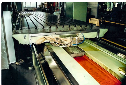
Verteilzentrale der Luftabhebung am Schlitten.
