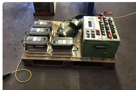
Demontierte alte Elektrik.
