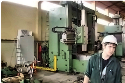
Start der Verkabelung.
