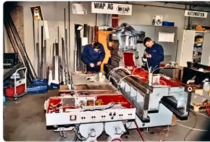
Schlittenführung neu mit SKC belegt.
