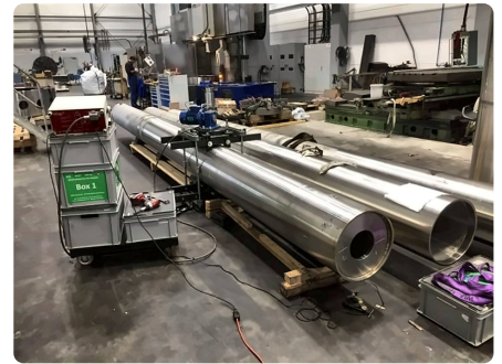
Mantelrohre werden entspannt.
