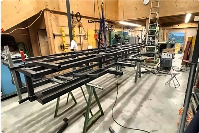
Schweisskonstruktion des Gestells in der Halle Dulliken.
