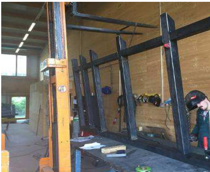
Bild 73: Jim beim Schweissen des Teile Ablage Unterrahmen
