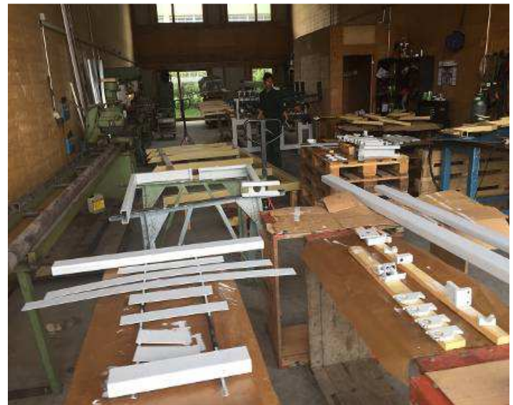
Bild 80: Immer wieder musste gemalt werden, dass in der Montage weiter gemacht werden konnte. Die Ware in die Spritzerei bringen und immer eine Woche warten hätte, dem Terminplan sehr geschadet. Zudem teuer diese sperrige Ware immer zu transportieren
