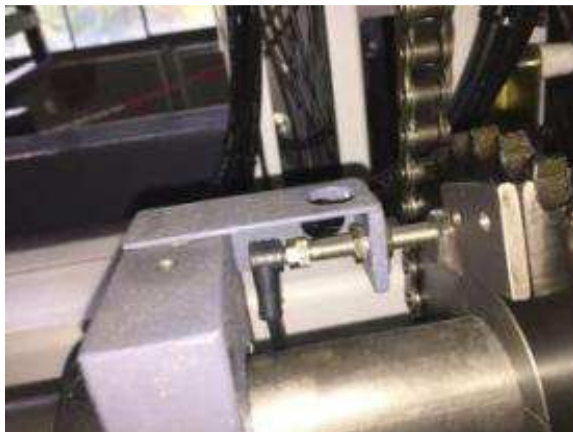
Bild 14c: Ein Annäherungsschalter stoppt die Kralle, wenn diese wieder unten ist.
