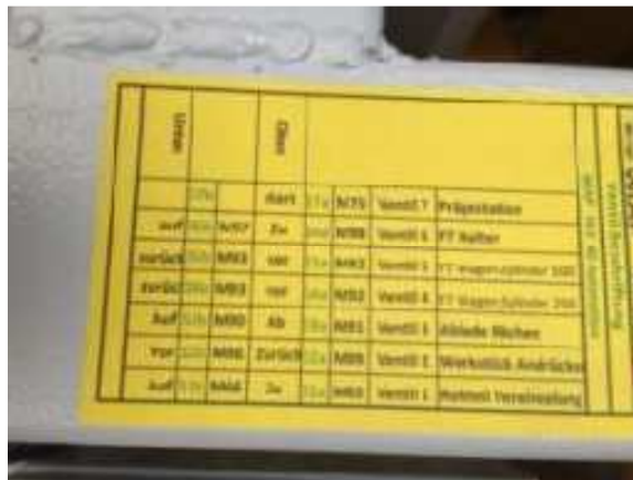
Bild 46b: Die ganzen Bewegungen gehen über M Funktionen. Mit Luft. Alle Ventile mit Mittelstellung für ein sicheres Notstopp System.
