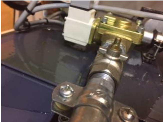
Bild 33: Die Wassermenge kann mit dem Hahn eingestellt werden. Das Wasserventil sorgt für die Ortsbestimmung der Emulsion.
