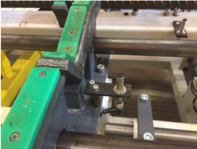
Bild 16: Die Lichtschranken 1 + 2 prüfen, ob ein Defekt vorhanden ist.
