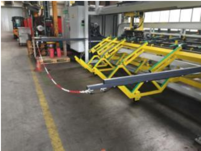
Bild 58d: Die ganze Anlage ist mit Horn und Stopp Zonen gesichert. Die Kette verhindert, dass unwissende Dritte in die Gefahrenzone kommen. Wenn jemand in die Stoppzone läuft, stoppt die ganze Anlagen. Es gibt ab und zu Leute, welche zu nahe kommen, weil sie antasten wollen, was sie sehen.
