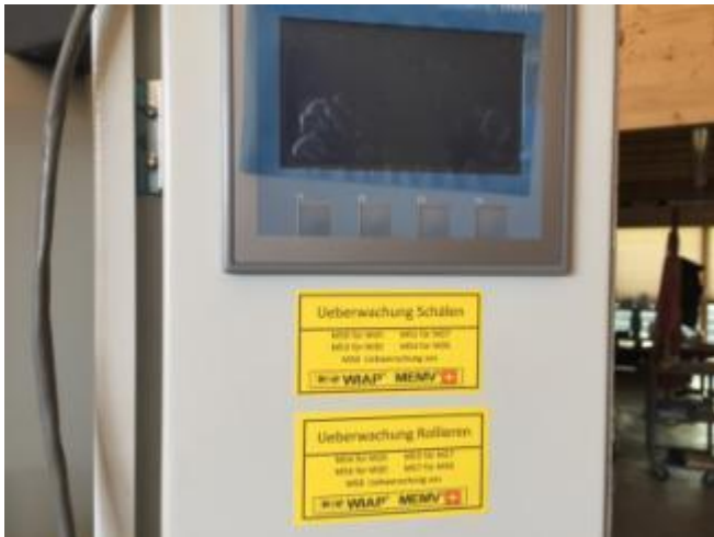
Bild 29b: Neben der Steuerung befindet sich das HMI, welches für die M Funktionen, Werkzeug-Verschleissüberwachung, Vibrator und Futter, zuständig ist.
