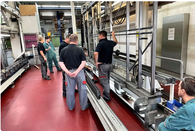
Inbetriebnahme des neuen Steuerungssystems.
