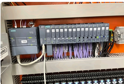
Neuer Elektroschrank nach dem Umbau.
