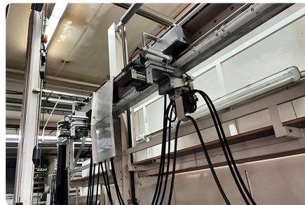
Verkabelung der Ventile und Zylinder.
