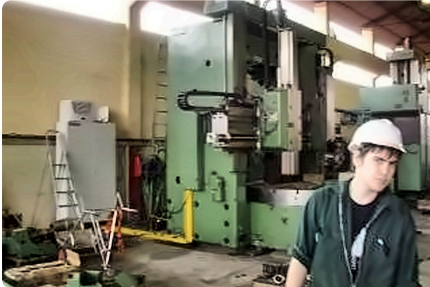
Start der Verkabelung.
