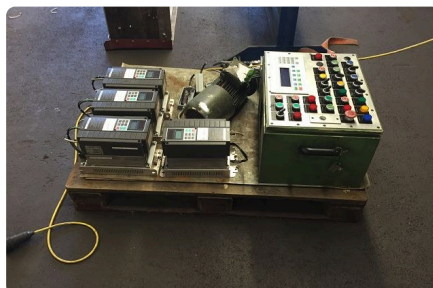
Demontierte alte Elektrik.
