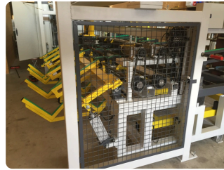
Verschaltung und Sicherung an der Beladeseite.
