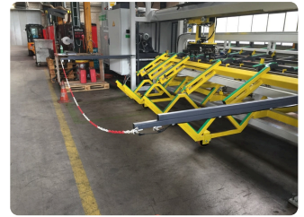
Sicherheitskette vor dem Lichtschrankenbereich.
