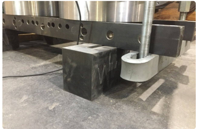
Gummiunterlage 100 × 120 × 200 mm unter der Spannvorrichtung.
