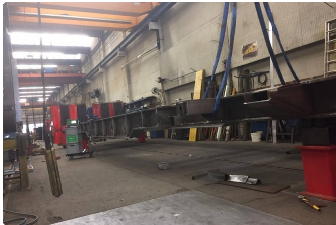
Gesamtansicht: die 14 m lange Konstruktion während der Behandlung.
