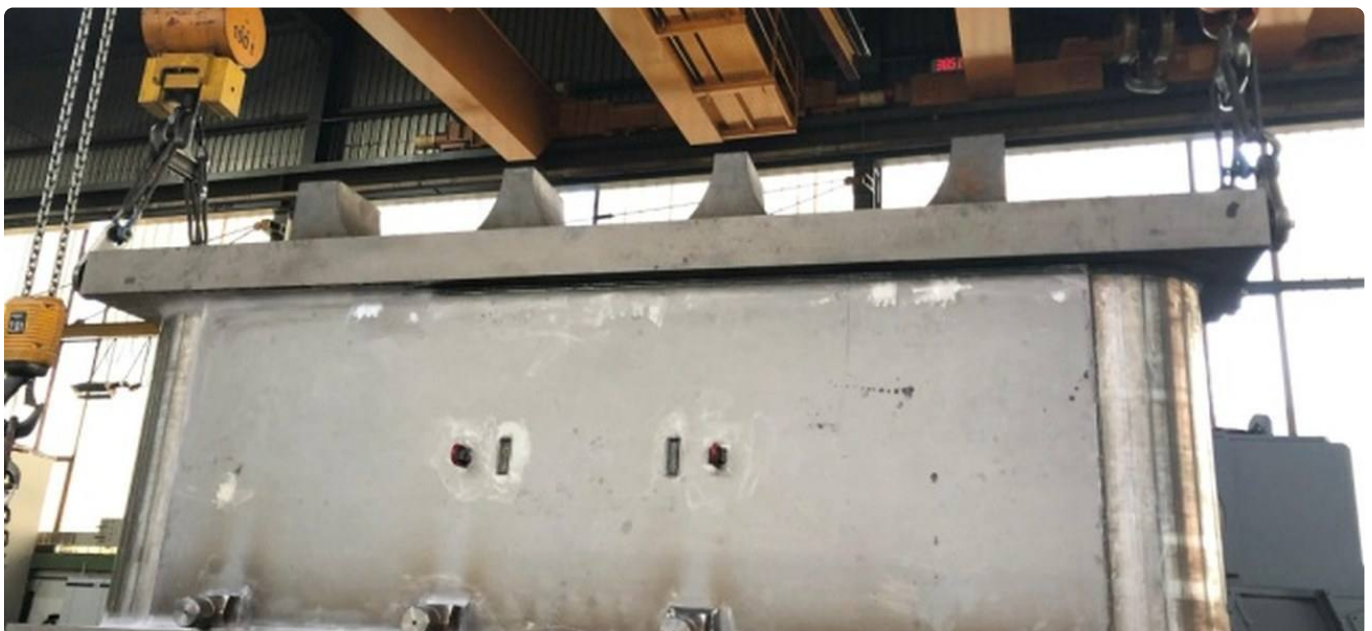
Das Bauteil hängt am Kran und wird auf die vorbereiteten Gummiunterlagen abgesetzt.
