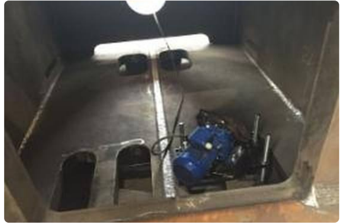
Der Erreger im Inneren des Bauteils, fest montiert.
